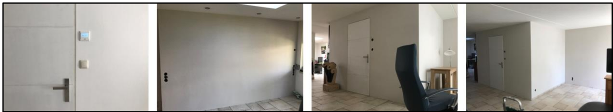
Bilder der fertigen Wandheizung
